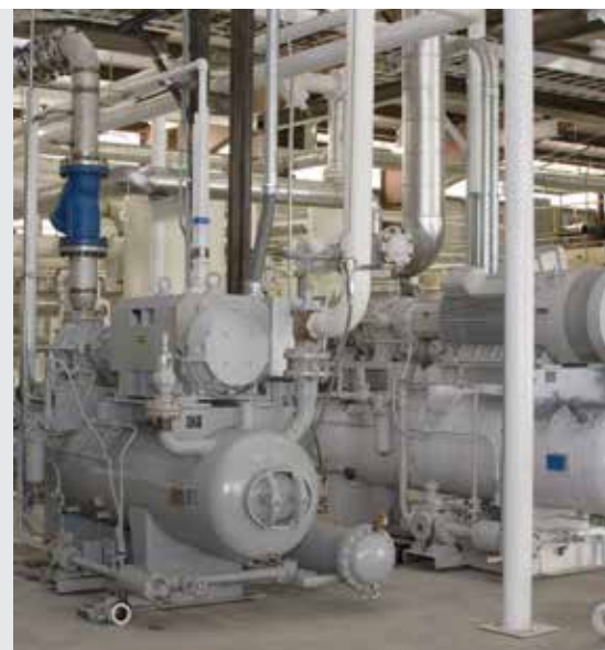
La régulation de la vitesse du compresseur principal et d'un compresseur supplémentaire augmente les possibilités de conception ; elle permet aussi un meilleur choix de taille de compresseur s'adaptant aux différentes conditions de charge à 60 Hz
